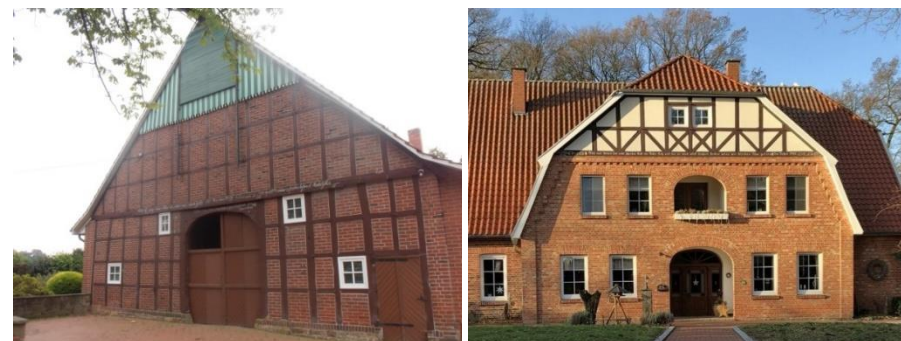
Abbildung 9. Beispiele für kombinierte Gebäudefassaden: Fachwerk auf Bruchsteinsockel mit Giebelverbretterung (Füstenauer Damm) und Klinkerfassade mit Ziermauerwerk und Fachwerk im oberen Drittel (Hauptstraße), Fotos: Büro für Landschaftsplanung, 2021 und Privatfoto
