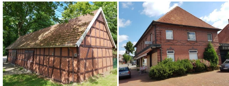
Abbildung 6. Beispiel für ein Satteldach (Engelerner Straße) sowie für ein Walmdach (Hauptstraße), Fotos: Büro für Landschaftsplanung, 2021
